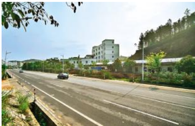
台海路台城出口路段扩宽工程完成
