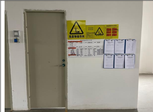
危险废物暂存间
