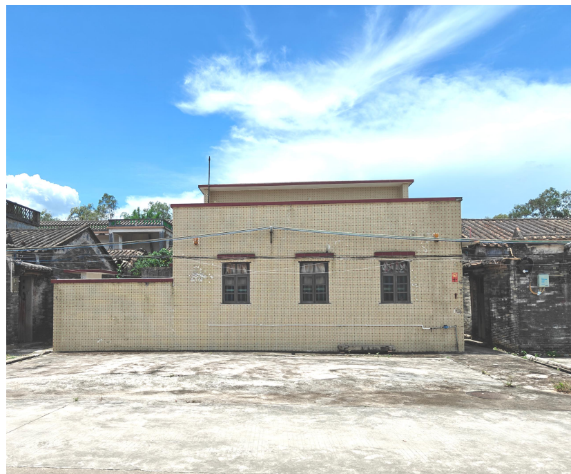
新建框架结构农房现状图
