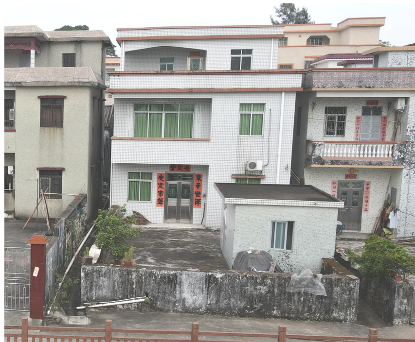
新建框架结构农房现状图
