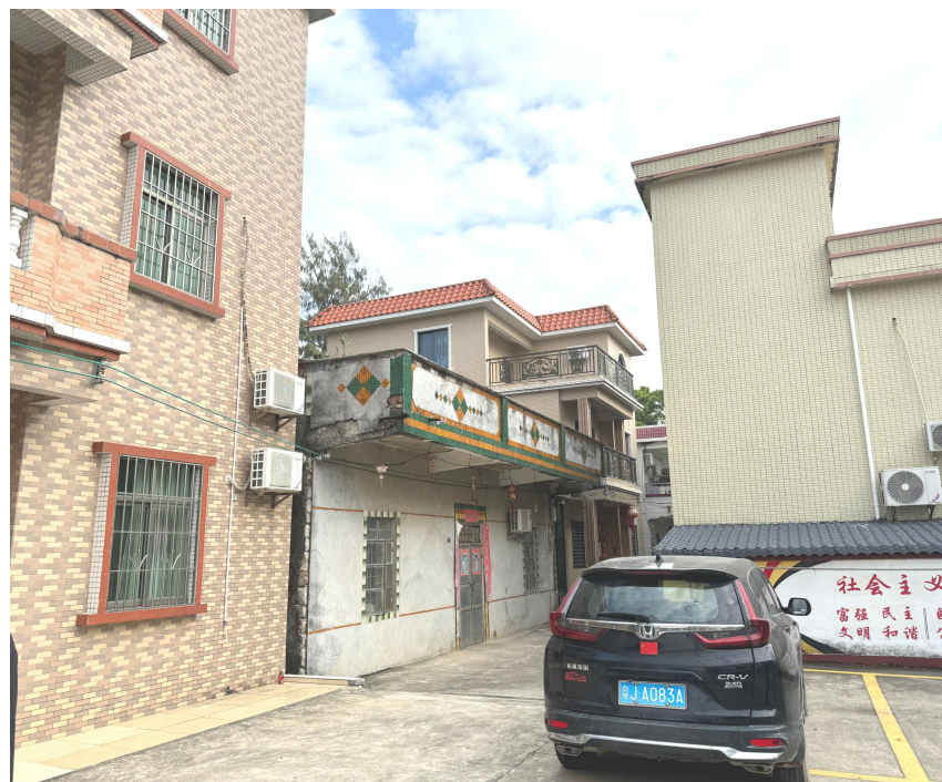
新建框架结构农房现状图
