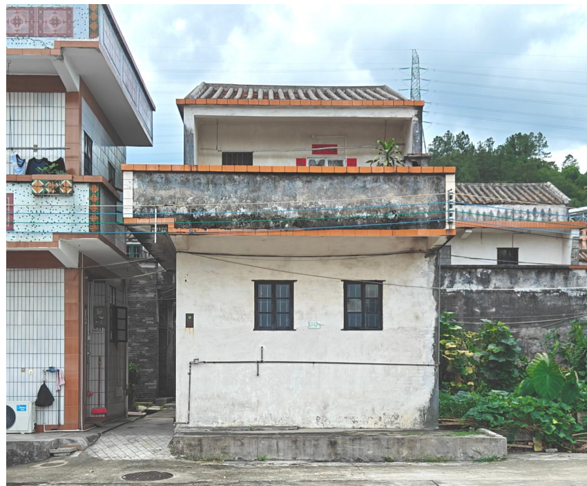
新建框架结构农房现状图
