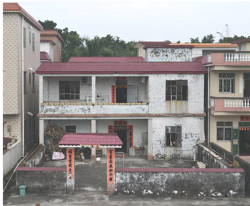
新建框架结构农房现状图
