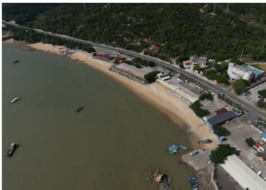
图 5.1.2-6 广海湾港区鱼塘湾海角城海浴场建设项目现场图片
