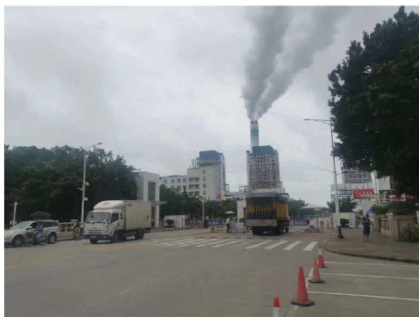
图 5.1.2-4 台山发电厂工程现场图片
