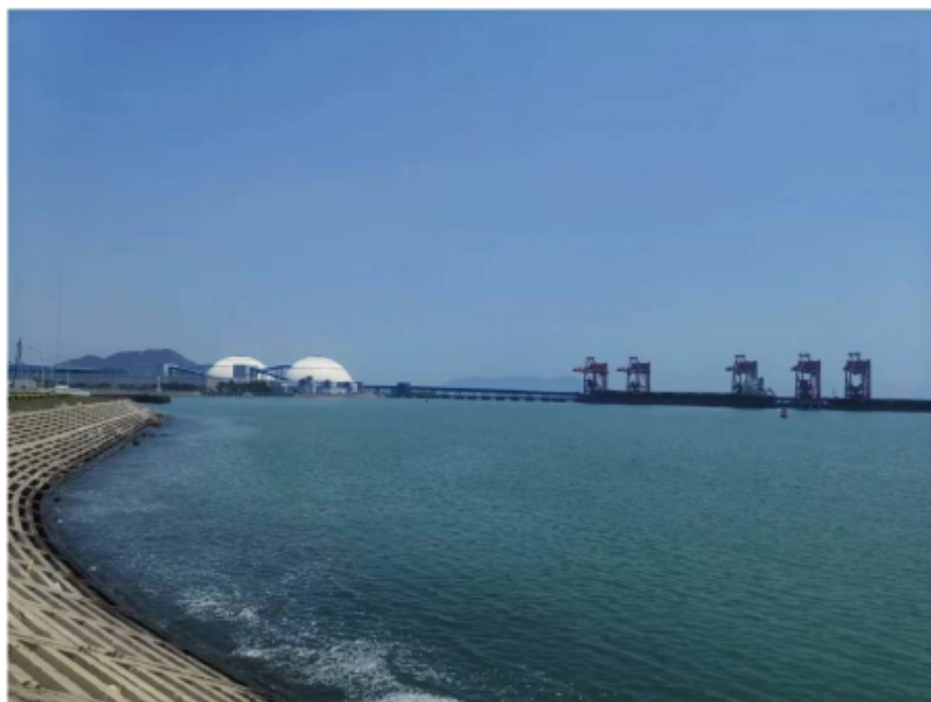
图 5.1.2-5 台山电厂 6、7 号机组“上大压小”扩建工程码头现场图片
