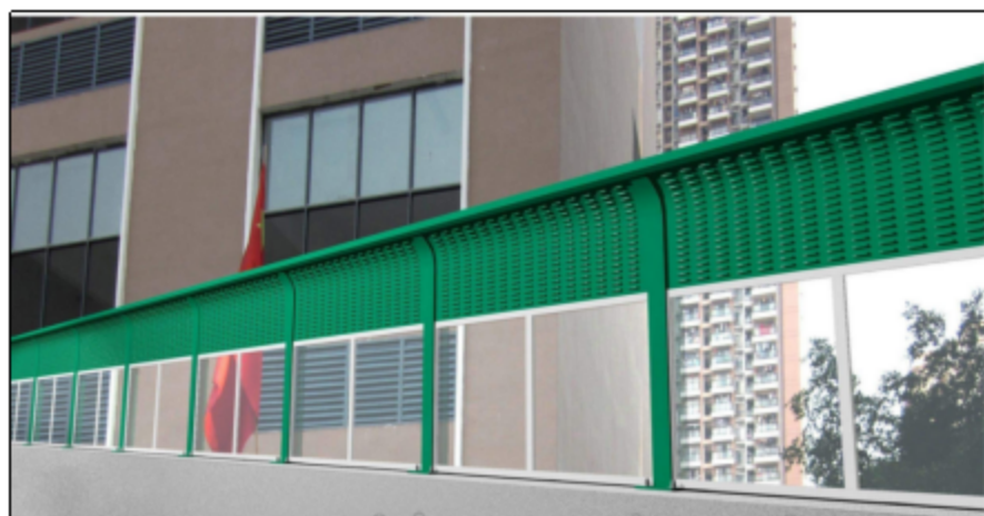
图 6.2-1 直立式声屏障工程实例图
