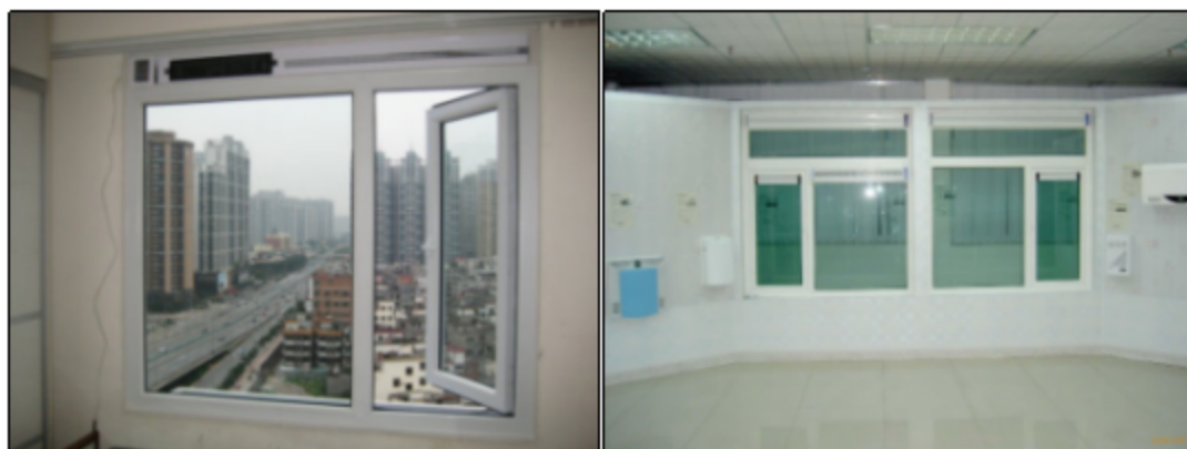
图 6.2-4 通风隔声窗应用实例
