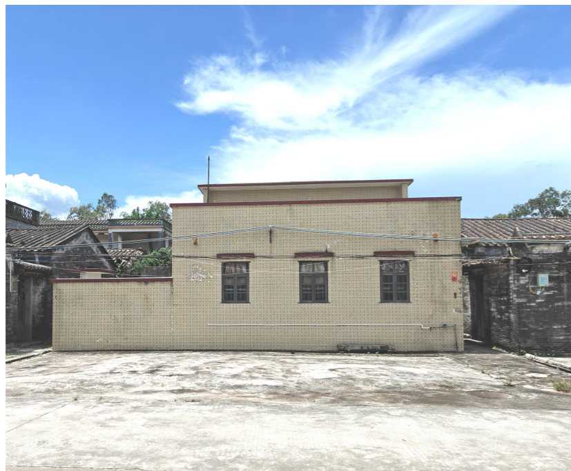
新建框架结构农房现状图
