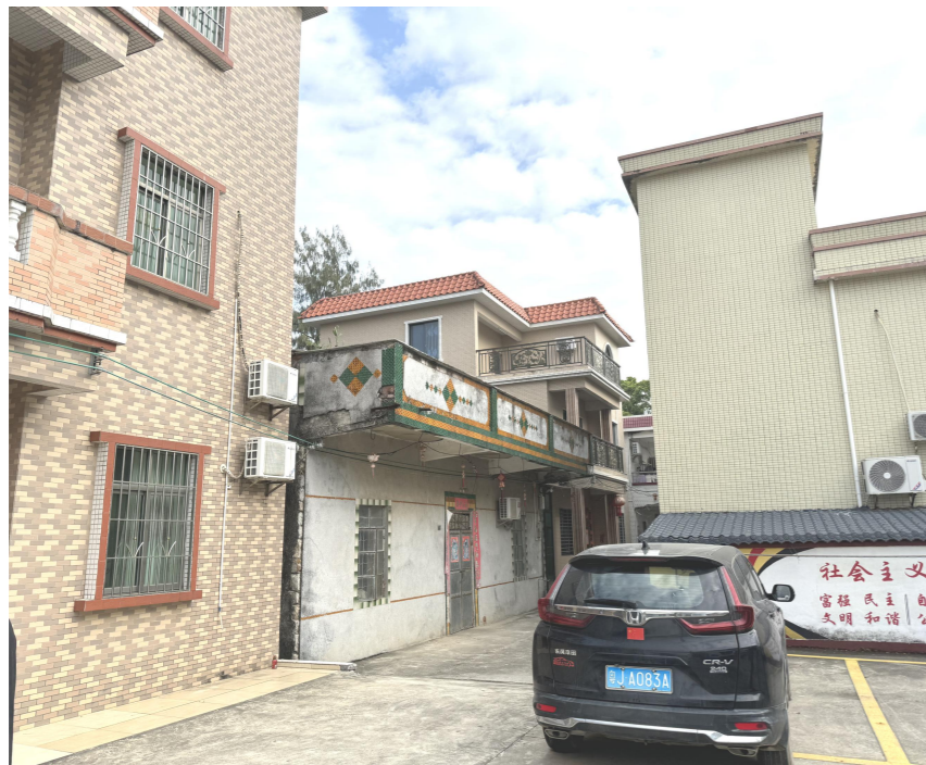
新建框架结构农房现状图
