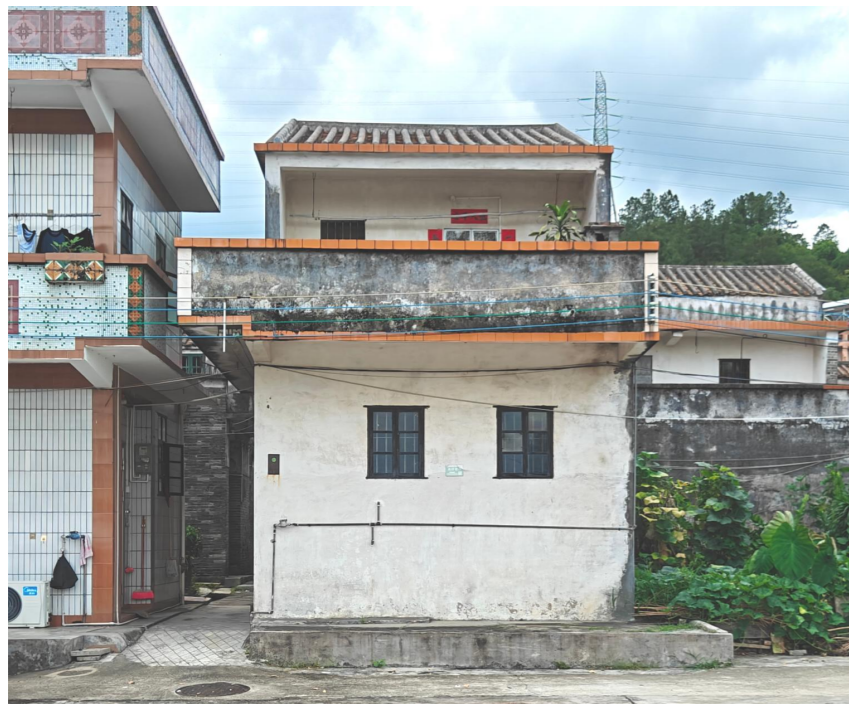
新建框架结构农房现状图
