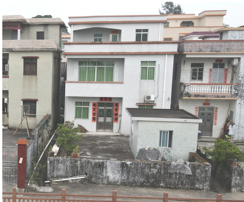
新建框架结构农房现状图
