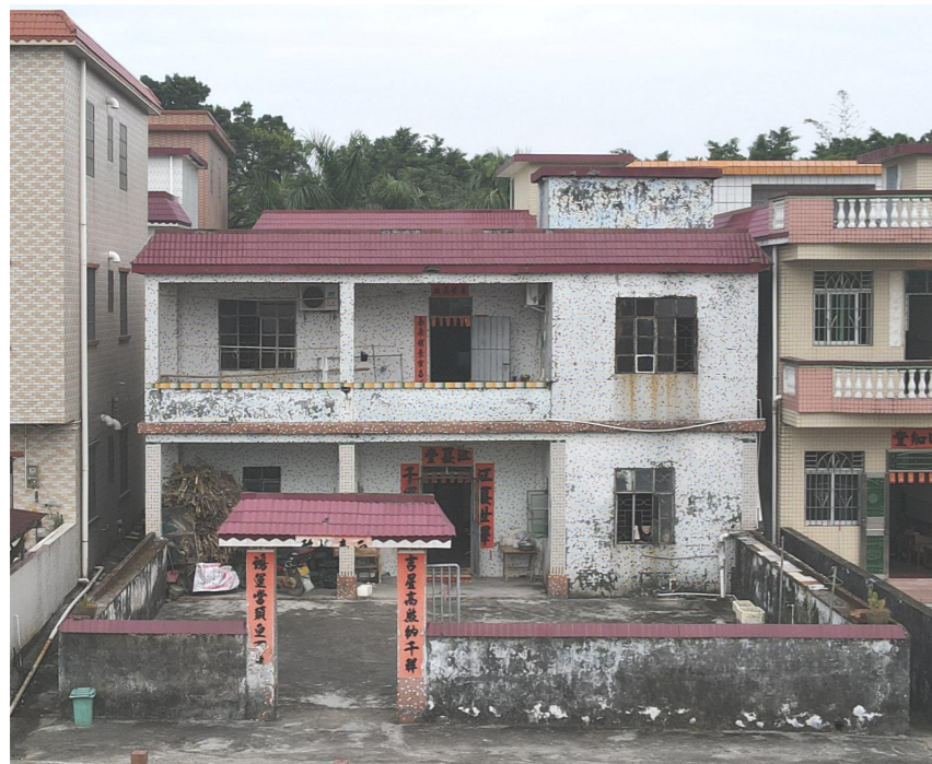
新建框架结构农房现状图
