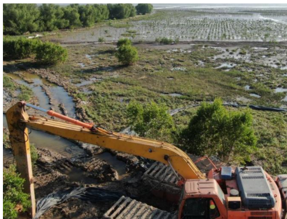
图 5.1.2-3 项目现场照片（1）
