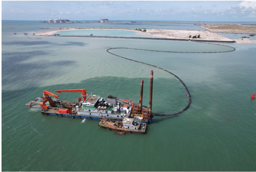
图 2.6.3-1 排泥管道铺设示意图
