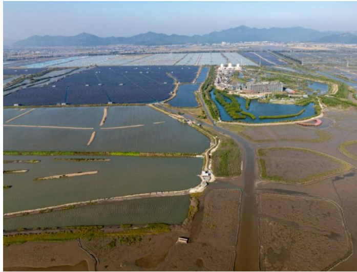
图 5.1.2-4 项目现场照片（2）
