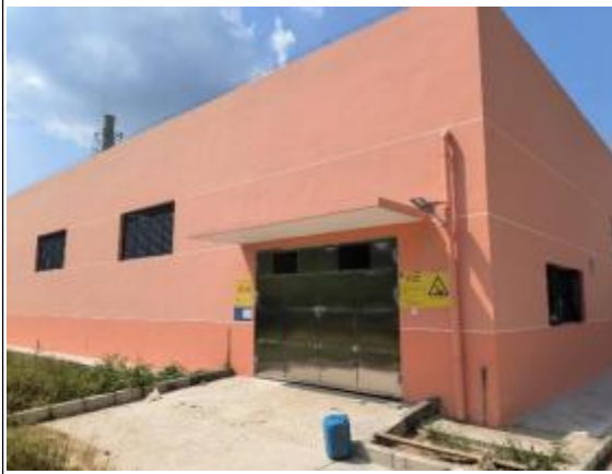
危废暂存间、飞灰养护间
