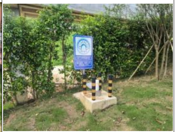
地下水监测井
