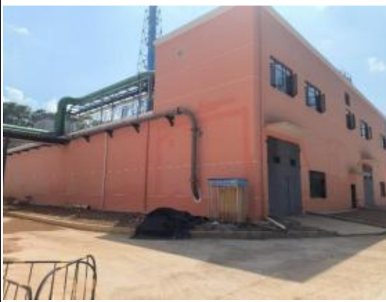
工业废水处理站
