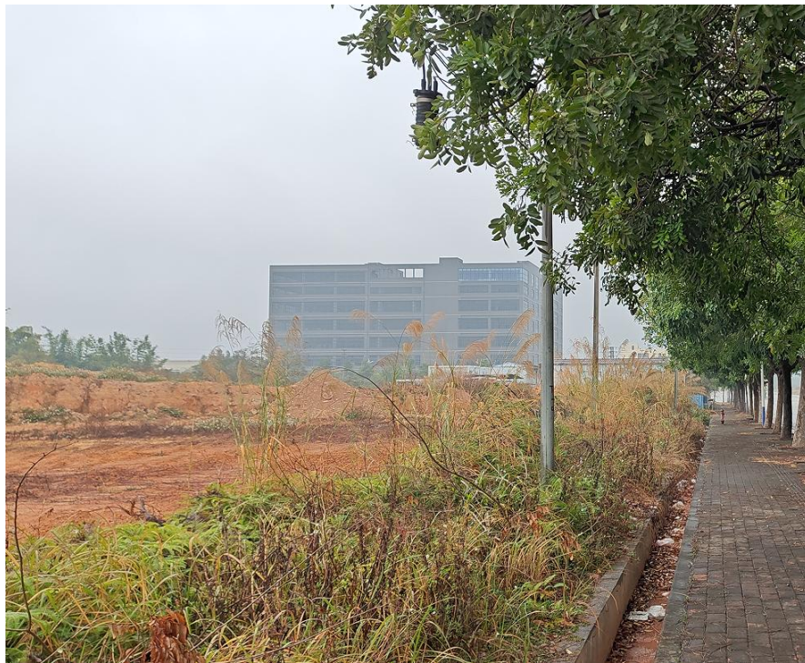
图 4-3 项目场址现状图
