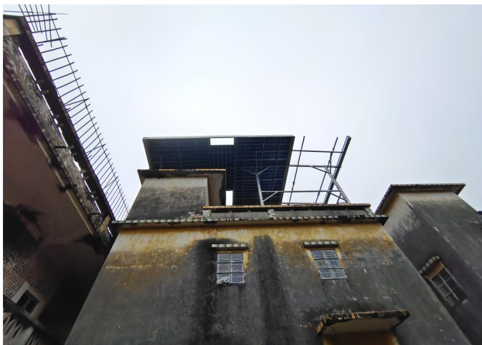
图二（事发现场-正在安装光伏板）
