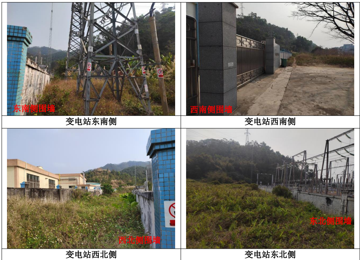
图 3-4 110kV 端芬变电站四周现状图
