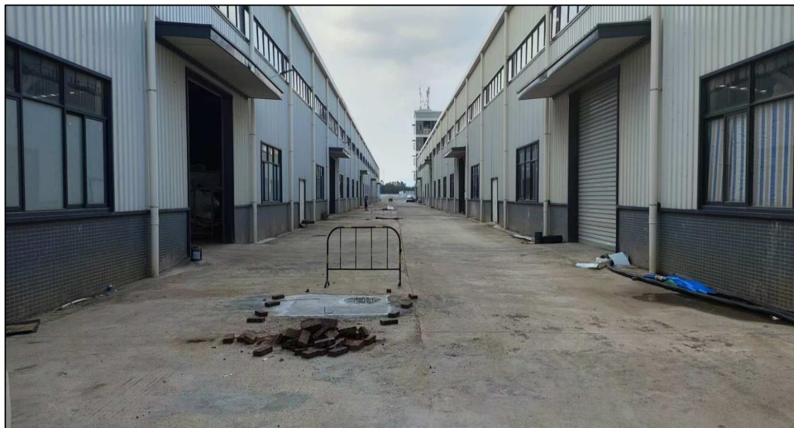
图 3-2 建设单位租赁场地硬底化情况图
