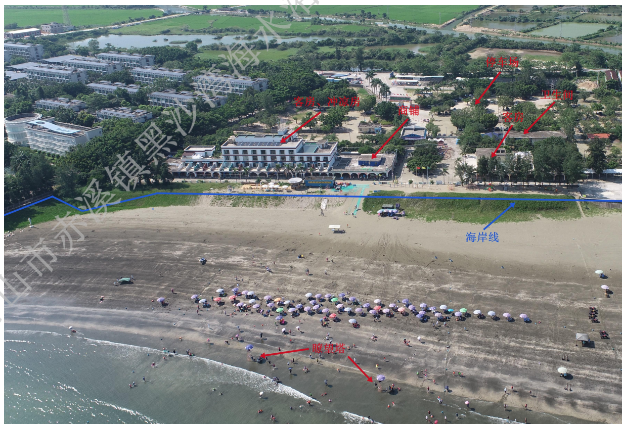
图2.2.1-2 配套设施及浴场现状照片
