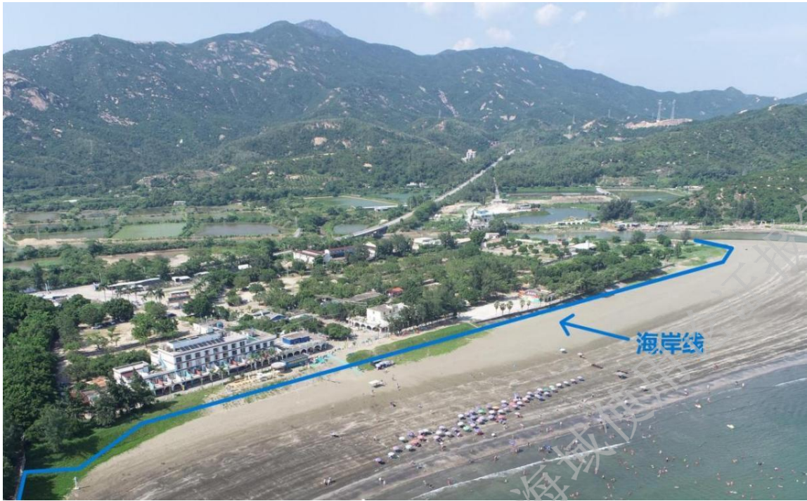
图5.1.2-4 岸线现状照片
