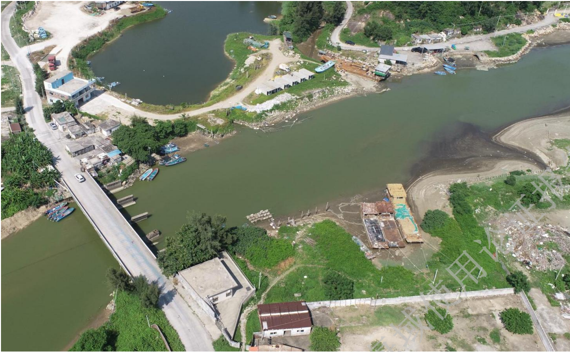
图5.1.2-2b 渔业码头现状照片
