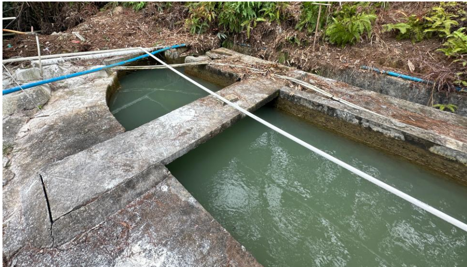
图 3-4 原供水收集水池及明渠
