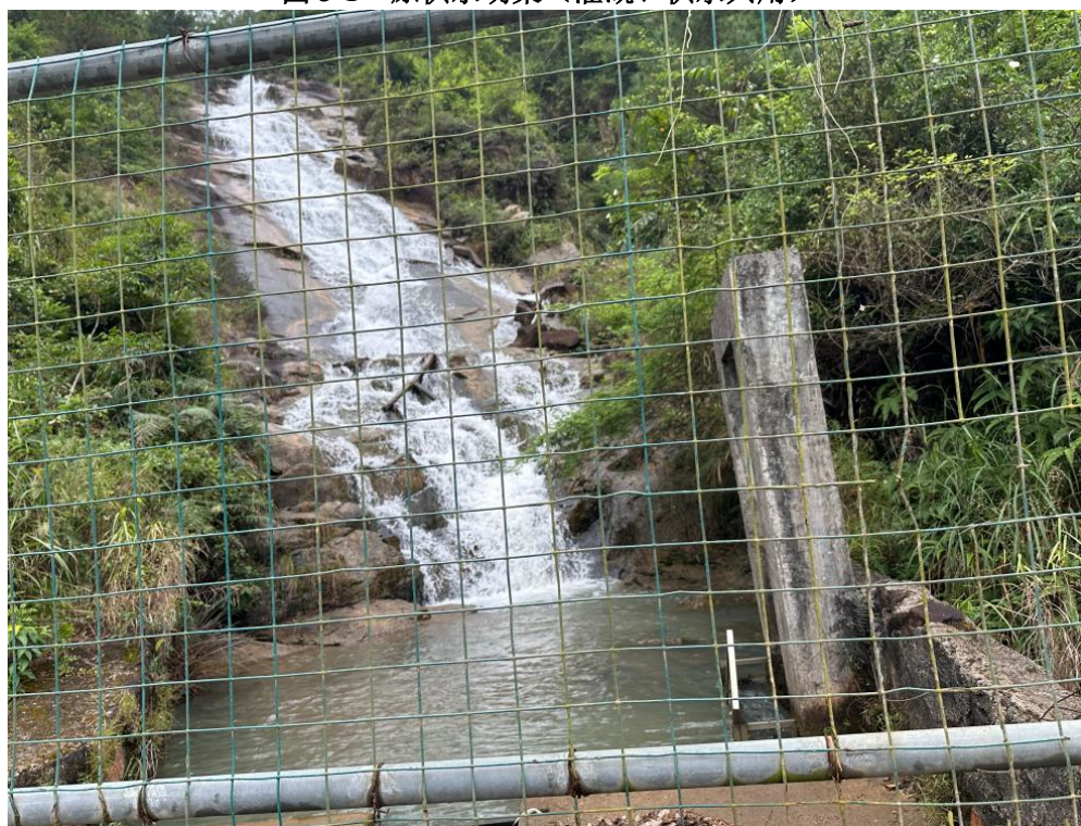
图 3-2 原供水收集水池
