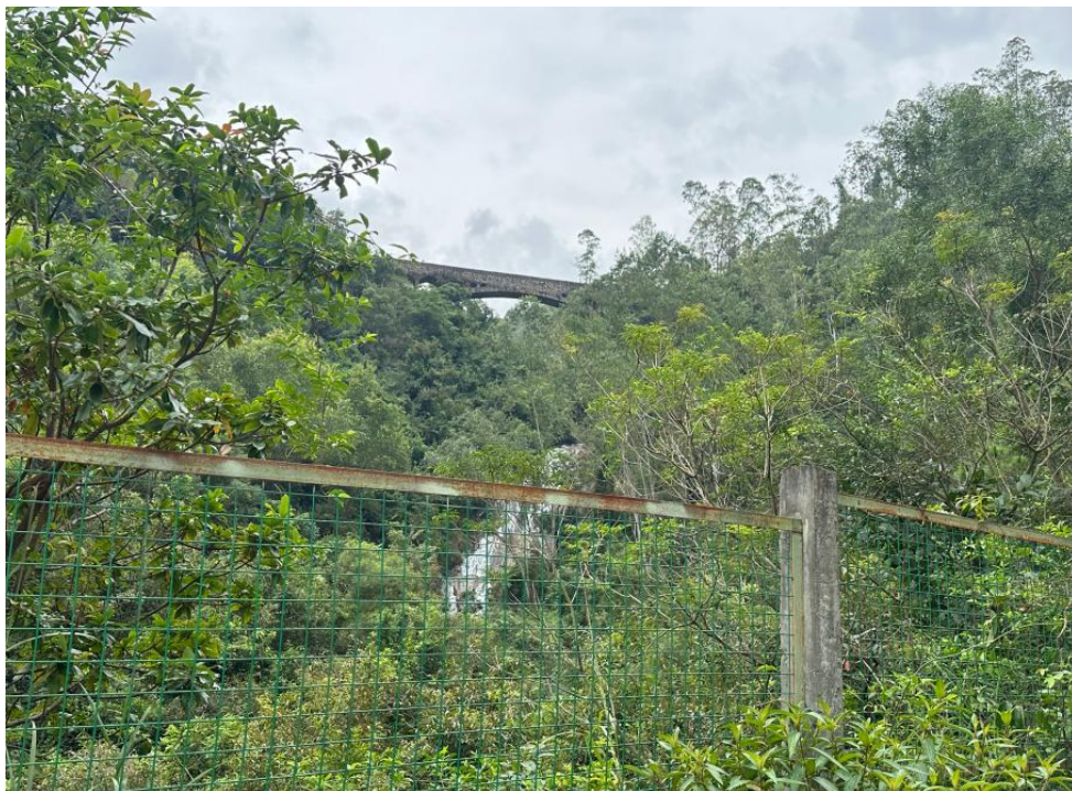
图 3-1 原供水明渠（灌溉、供水共用）
