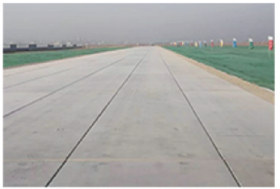
利用原路基加设装配式混凝土路面
