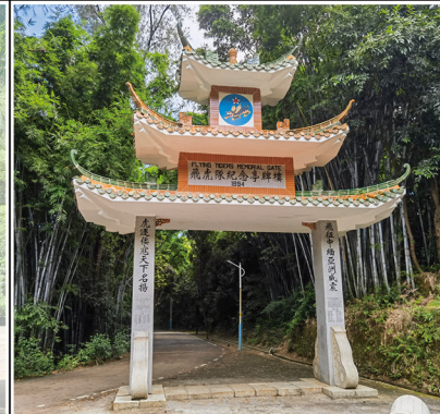
纪念亭牌楼北立面 (2)
