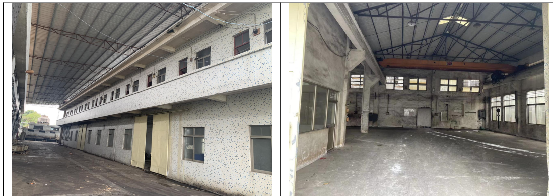
图 4 项目现场踏勘图
