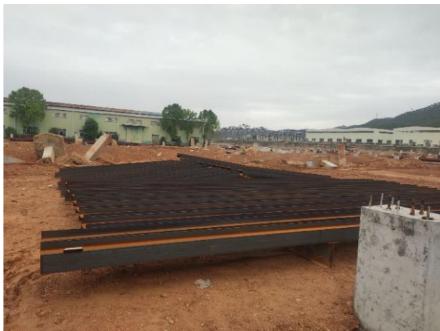
东面-名企汇志高工业园区厂房
