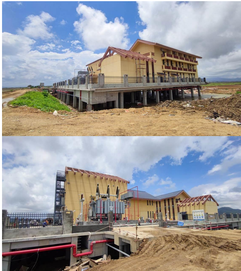
图 2-3 在建 220kV 升压站现场施工
