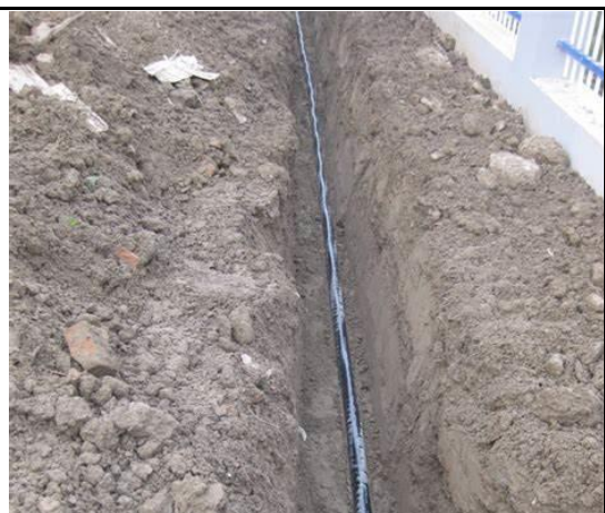
图 2-8 电缆直埋施工示意图
